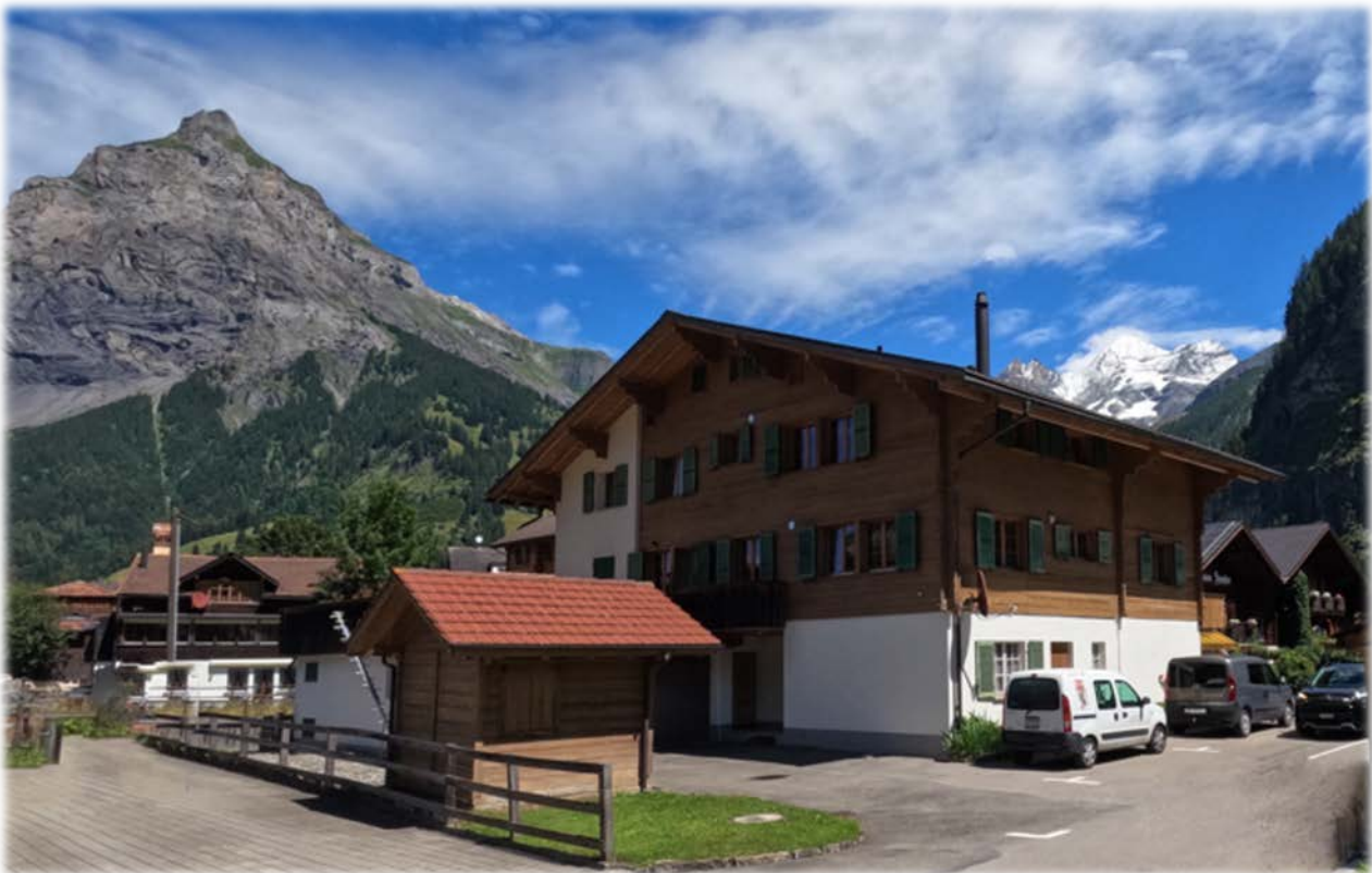
Aussicht von der Edelweissstrasse 2
